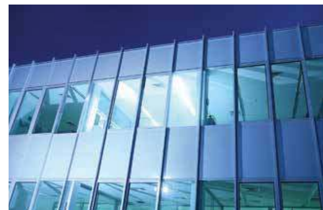
Офисно-производственно-складской комплекс, Московская область, г. Лобня
