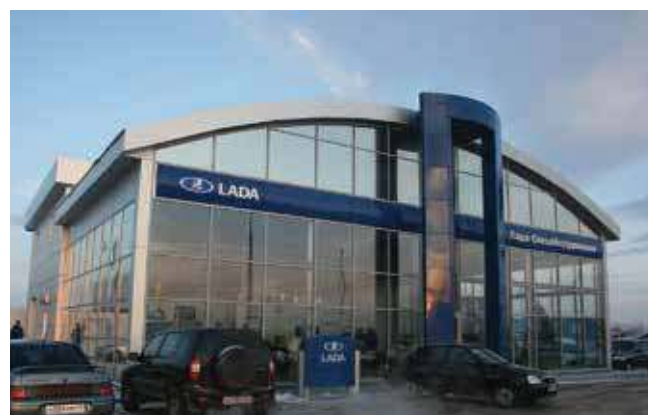
Технический центр по продаже и обслуживанию автомобилей ВАЗ «Ладаспецоборудование», г. Тольятти
